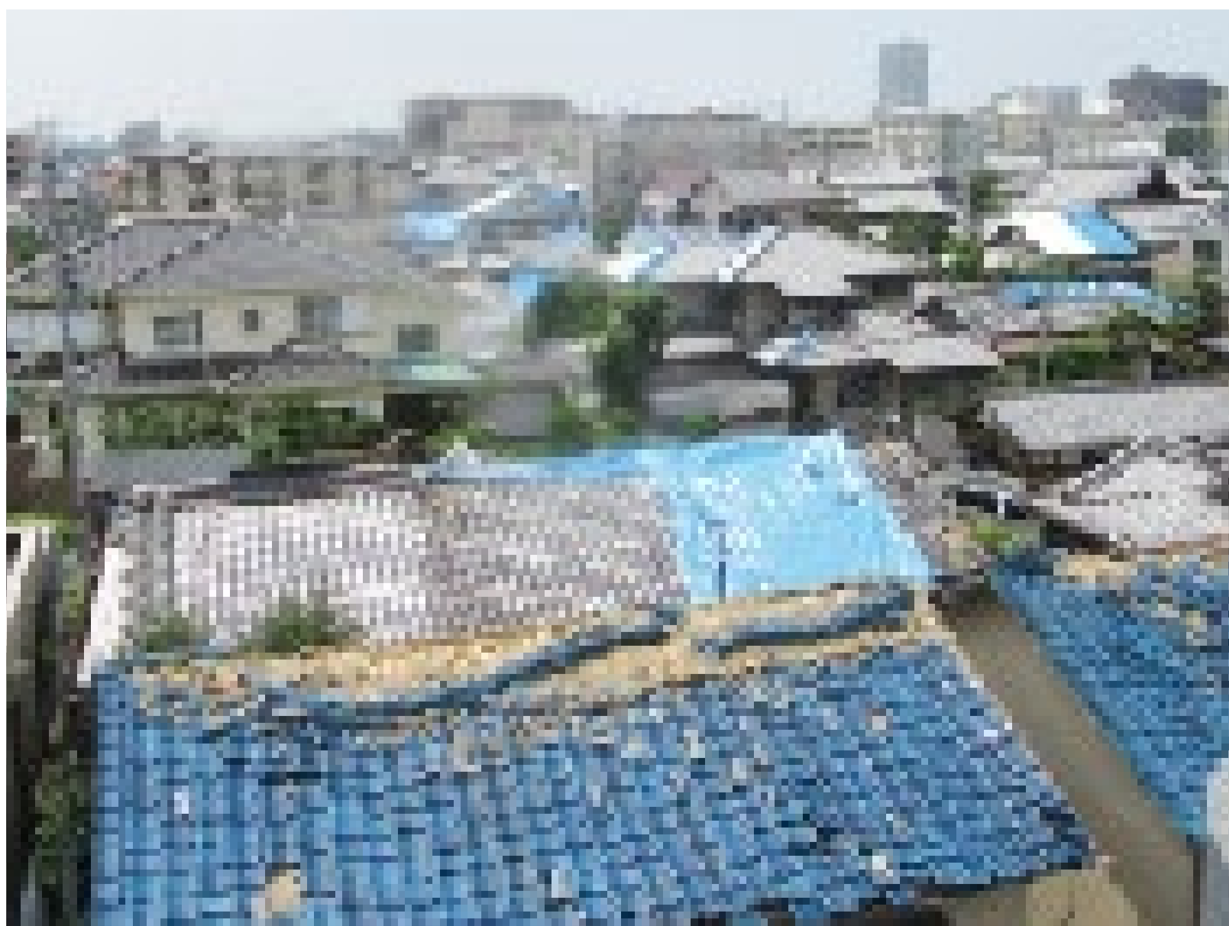
屋根瓦に被害のあった住宅
