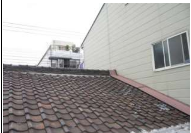
yane-5. 棟瓦に沈みが見られる
