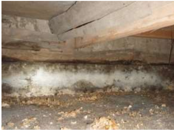
yuka-5. 水廻りの土台に腐朽が見られる
