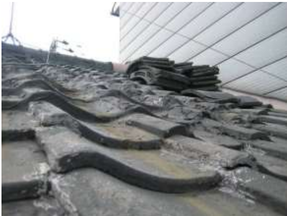
yane-4. 瓦にずれが見られる
