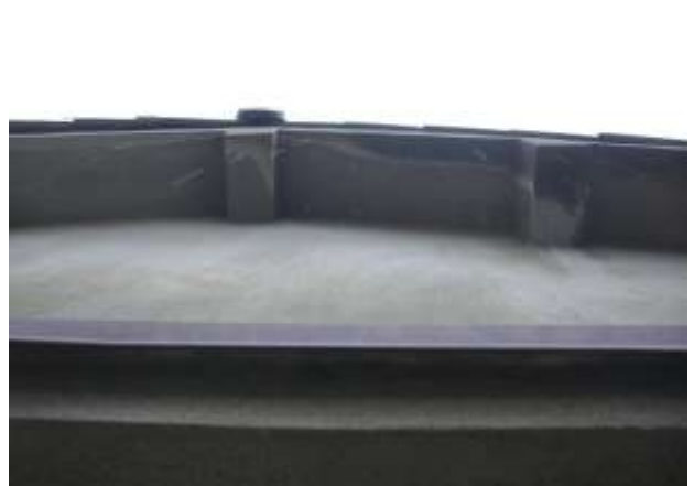
yane-5. 棟瓦に沈みが見られる
