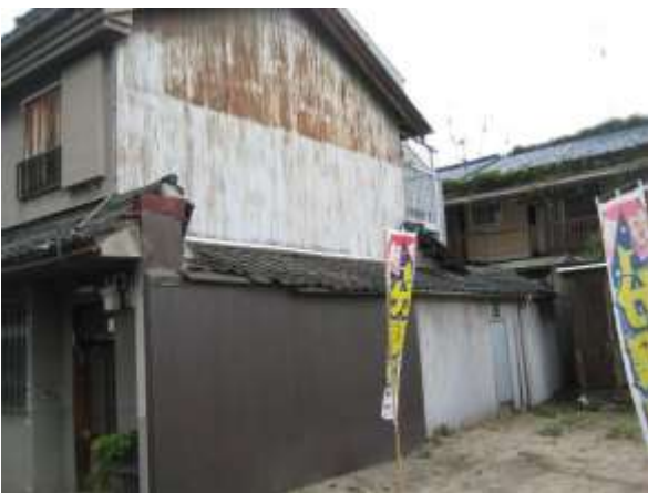
yane-4. 瓦にずれが見られる
