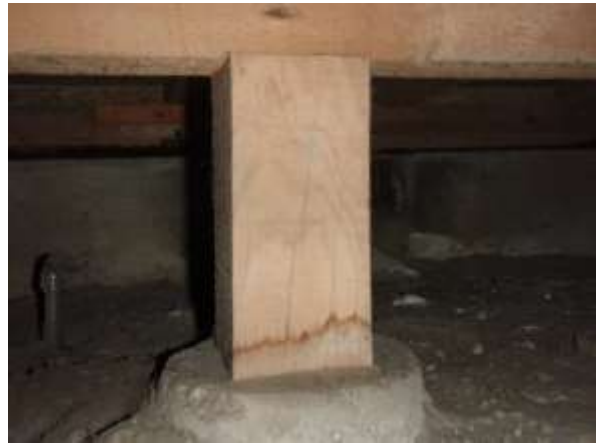
yuka-2. 床束が変色しているが乾燥している
