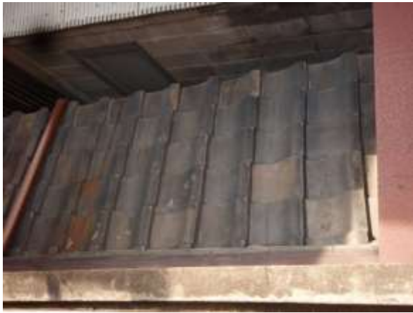
yane-1. 瓦にずれ・欠け等は見られない
