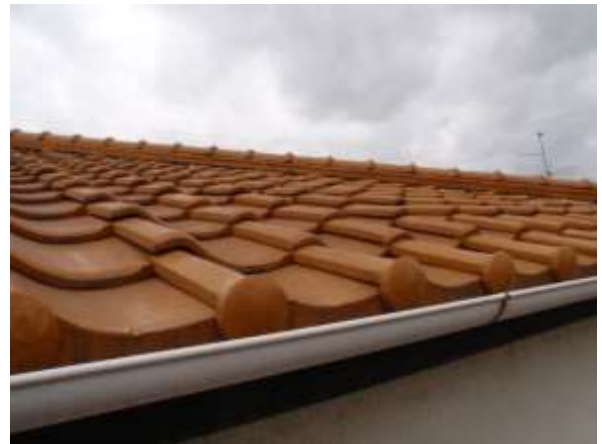
yane-3. 屋根ケラバに雨水浸入の後が見られる
