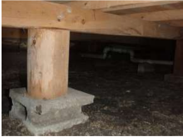
yuka-1. 床束が変色しているが乾燥している
