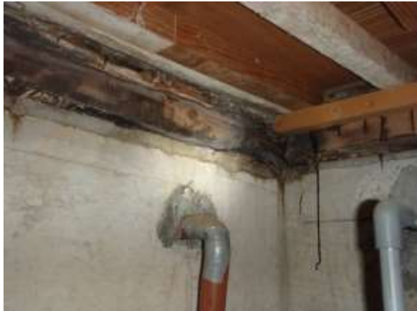
yuka-5. 水廻りの土台に腐朽が見られる
